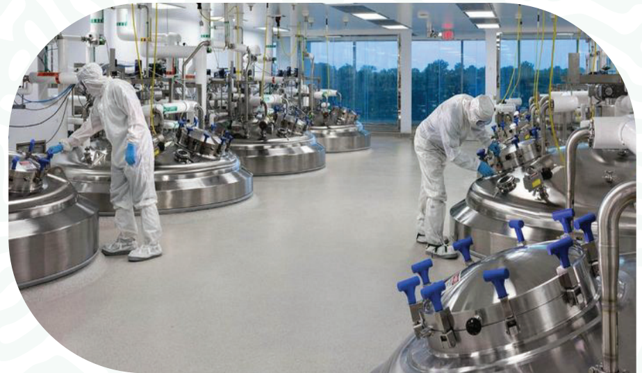
Serbatoi di miscelazione chimica
